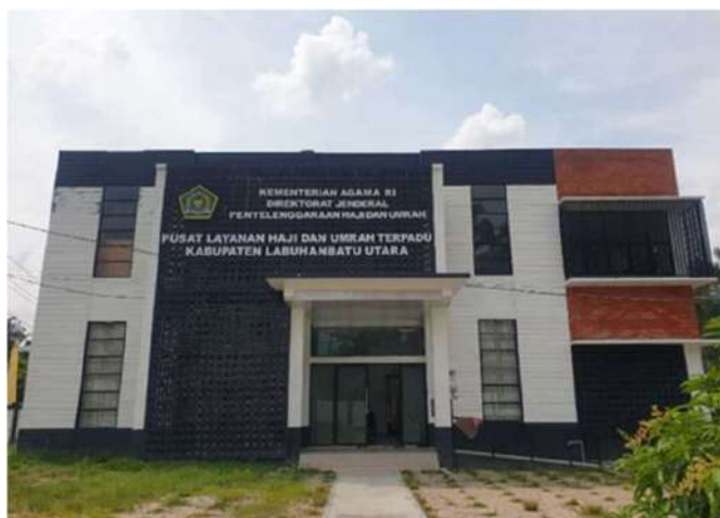
Gambar 3.11 Gedung PLHUT Kankemenag Kabupaten labuhanbatu Utara
